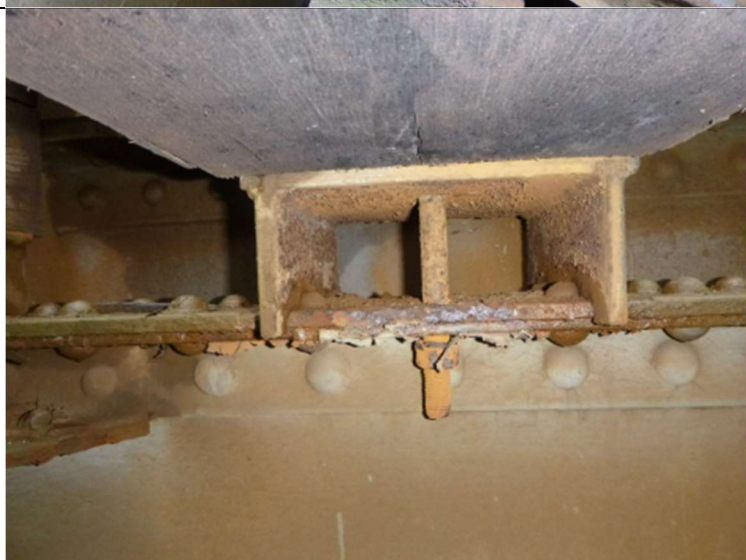
Obr. 77 – Pohled na „stoličku“ v místě uložení mostnice
