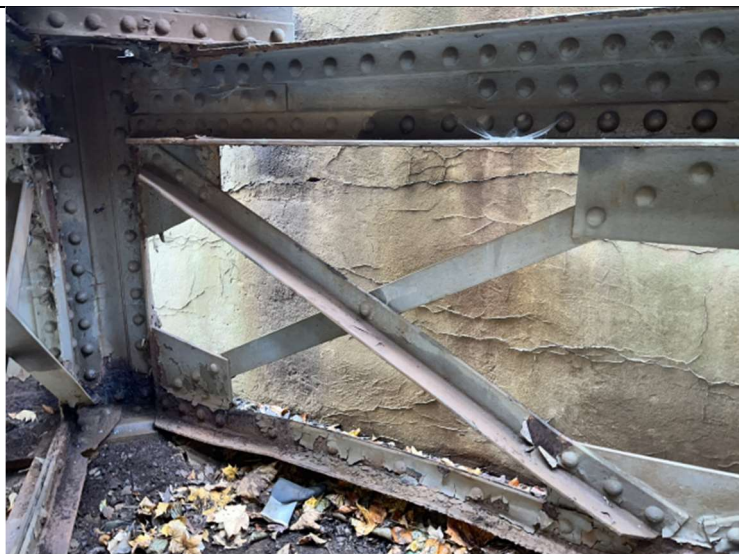
Obr. 74 – Deformace diagonálního koncového ztužení nad O01, pravá
