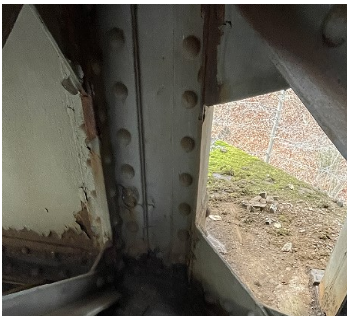
Obr. 187 - Snímek odběrového místa korozních produktů K2
