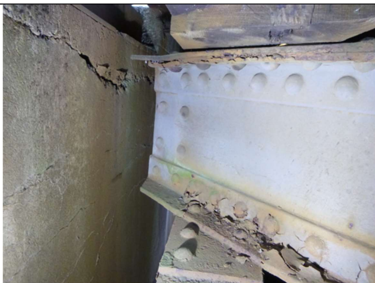
Obr. 76 – Deformace konce podélníku nad O02, levá
