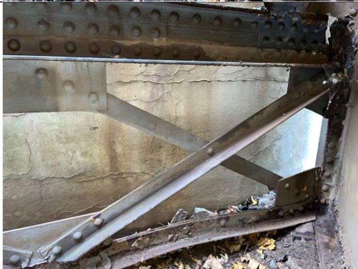
Obr. 75 – Deformace diagonálního koncového ztužení nad O01, levá
