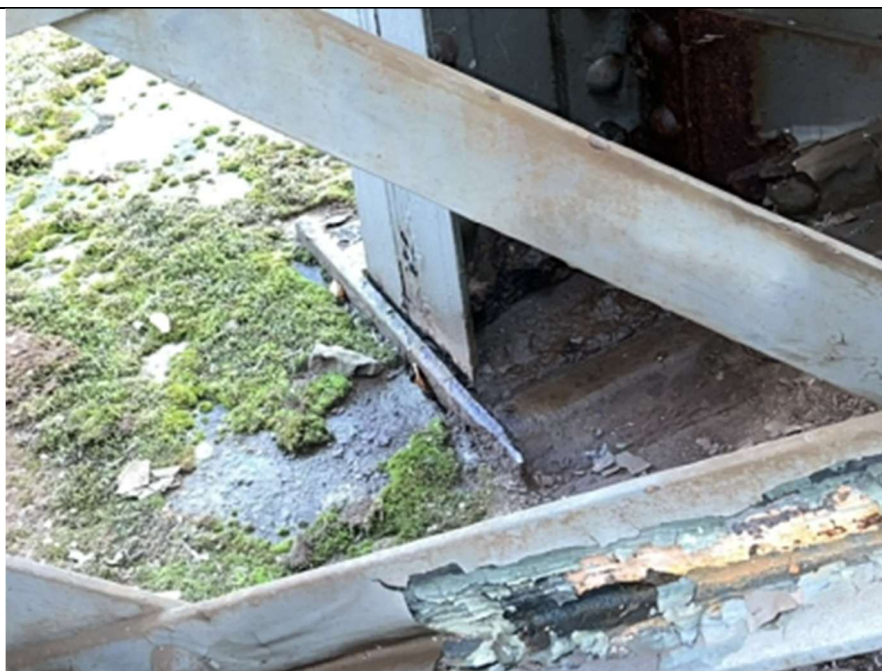
Obr. 233 – Koroze ložiska na P1
