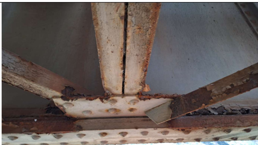
Obr. 232 – Pohled na typické korozní poškození – v místě napojení styčnickového plechu
