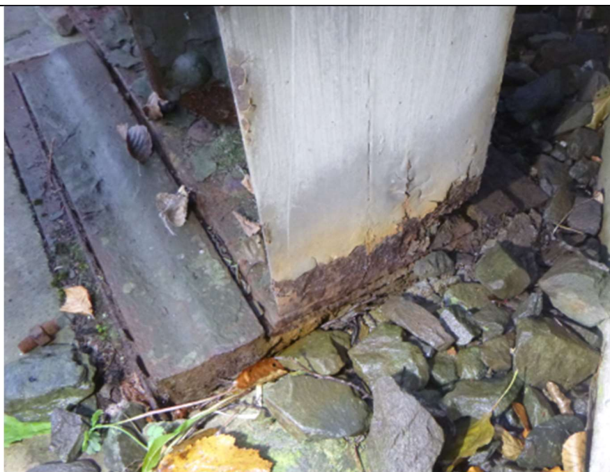
Obr. 234 – Koroze ložiska a zanesené vodící drážky
