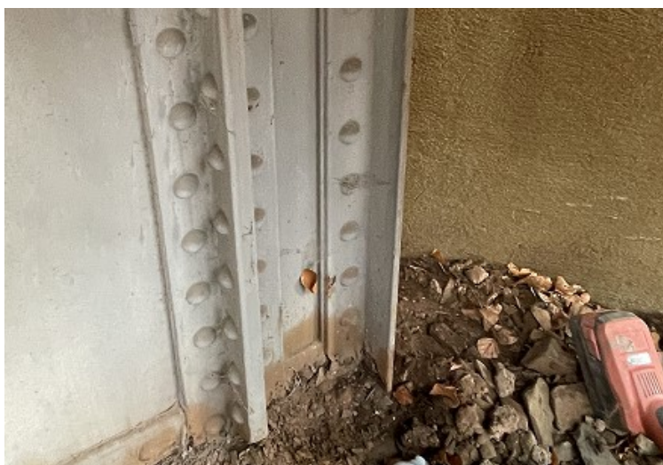
Obr. 186 - Snímek odběrového místa korozních produktů K1
