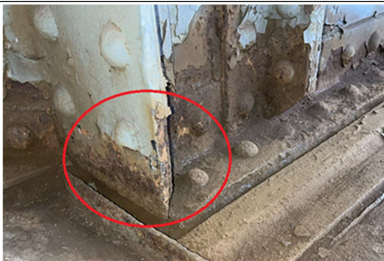
Obr. 129 – Pohled na povrch stojiny s částečně odprýsknutým nátěrovým systémem především v oblasti paty stojiny
