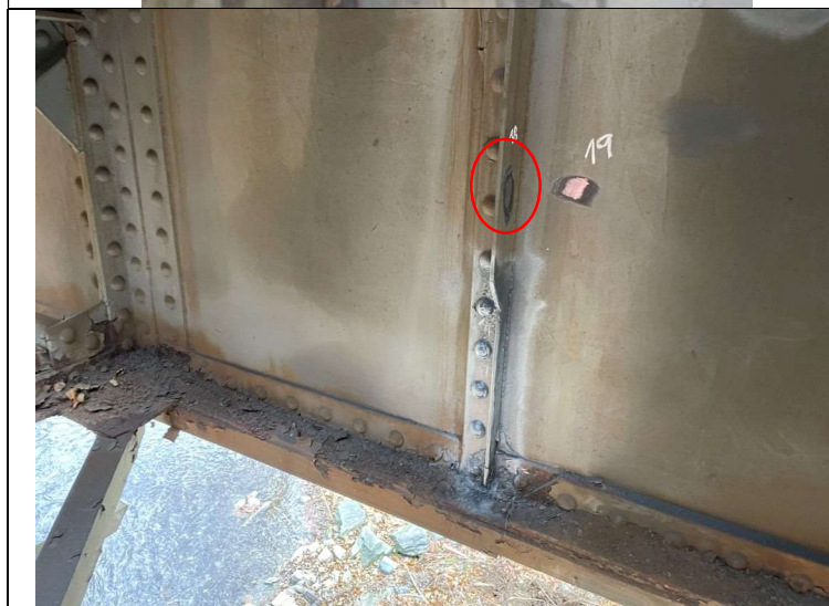
Obr. 99 – Měření tvrdosti dle Brinella
