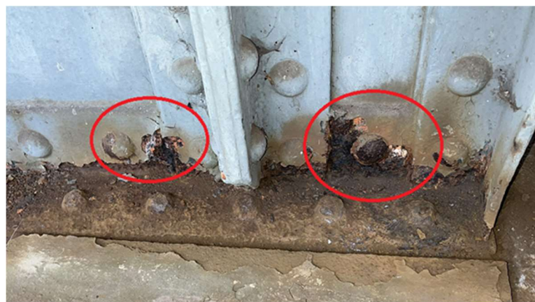
Obr. 130 – Pohled na povrch stojiny s částečně odprýsknutým nátěrovým systémem především v oblasti paty stojiny – II
