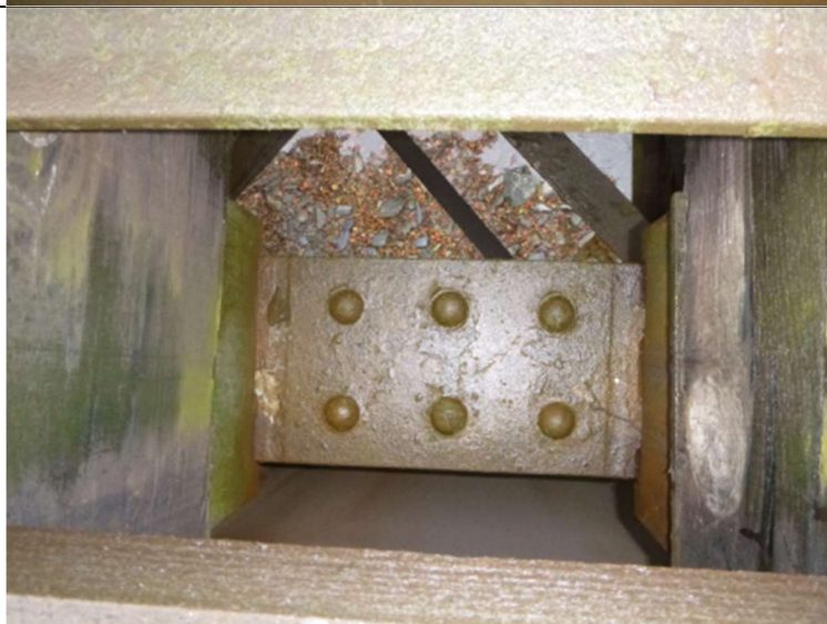
Obr. 78 – Deformace od „stoličky“ pro uložení mostnice
